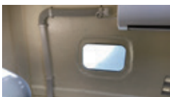
(24-3)100V エアコン用 コンセント
