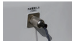
(24-1)100V 引込ケーブル
