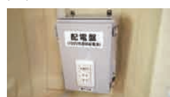
(20)100V電源引込装置(室内)*2
