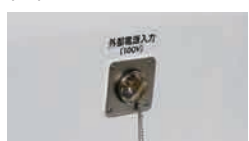
(20)100V電源引込装置(室外)*2
