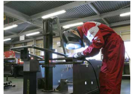
スペースフレーム製作（スチール材）
