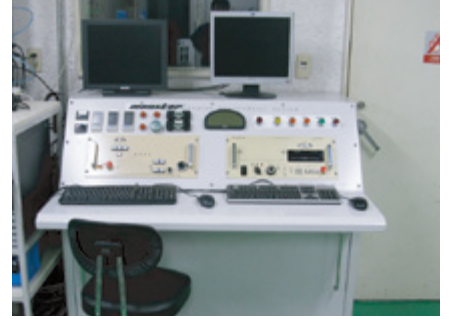
エンジンベンチ設備 制御盤
