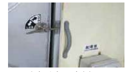
(23)乗降手すり(内側)
