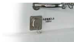
(20)100V電源引込装置 (室外)*2
