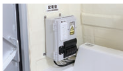
(20)100V電源引込装置(室内)*2
