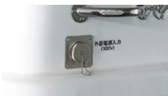
(20)100V電源引込装置(室外)*2
